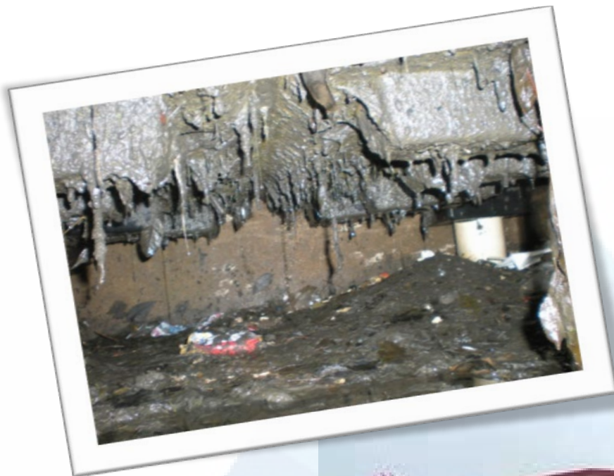
Vue de l'efficacité de Rétention du système (déchets, sédiments, huile et hydrocarbures) Plus de 90% de rétention
